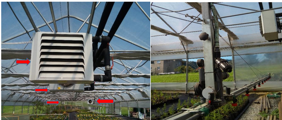
Slika 7: Toplovodni kaloriferji in namakalni sistem za avtomatsko zalivanje, (Foto: A. Korez, 2015)
